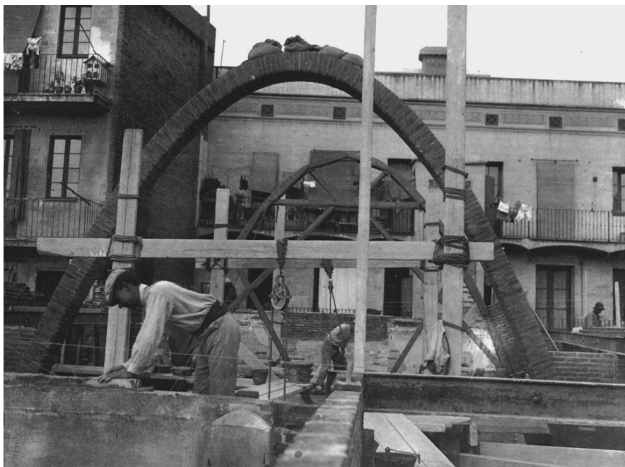
Construcció dels arcs parabòlics de la sala d'actes del Centre Moral i Instructiu de Gràcia, 1914. Arxiu del Centre Moral Instructiu de Gràcia.
